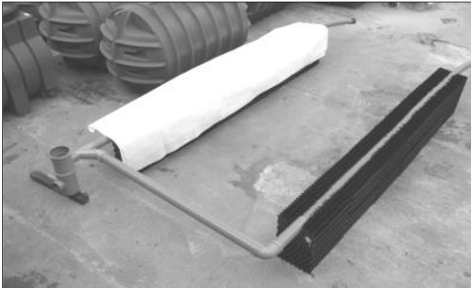
Anschluss eines zweiten Sickerstrangs an den Kontrollschacht mit KG-Rohren
