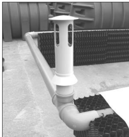
Anschluss Dunsthut bei zwei Sickersträngen.
